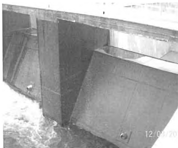
Сн.1 Общ облик на съоръжението - водобойна стена с 4 броя преливници
