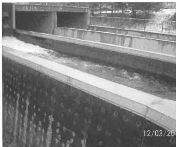
Сн.2 Съществуващ предпазен елемент-мостра
