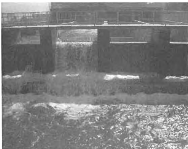
Сн.1 Общ облик на съоръжението - водобойна стена с 4 броя преливници
